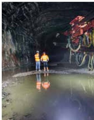
Глубоко под землей под Эспоо проходческая установка DT1131i осуществляет выемку породы для сооружения гигантской сети туннелей.
